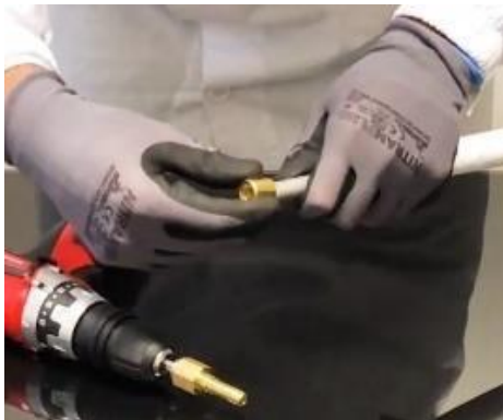
Instalace koncovky na potrubí
