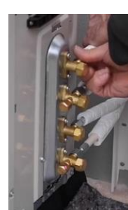
Montáž na klimatizaci
