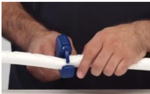
Stříhání potrubí univerzálními nůžkami
