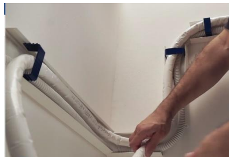
Velmi jednoduché ukládání potrubí do žlabu
